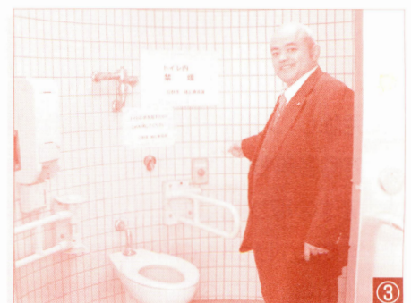
河内公園のトイレにも緊急通報装置の設置を
