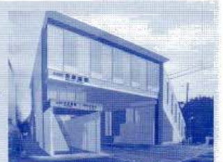
平成22年9月完成予定の新百草園駅
